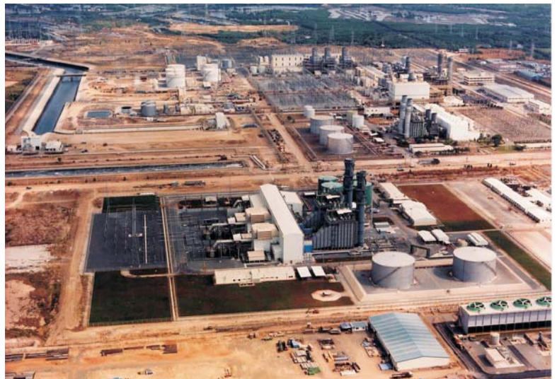
Bild 1 Industriekomplex Phu My mit GUD Kraftwerk im Vordergrund
