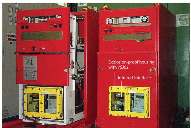
Fig. 2 Siemens Bartec 8SN encapsulated switchgear
