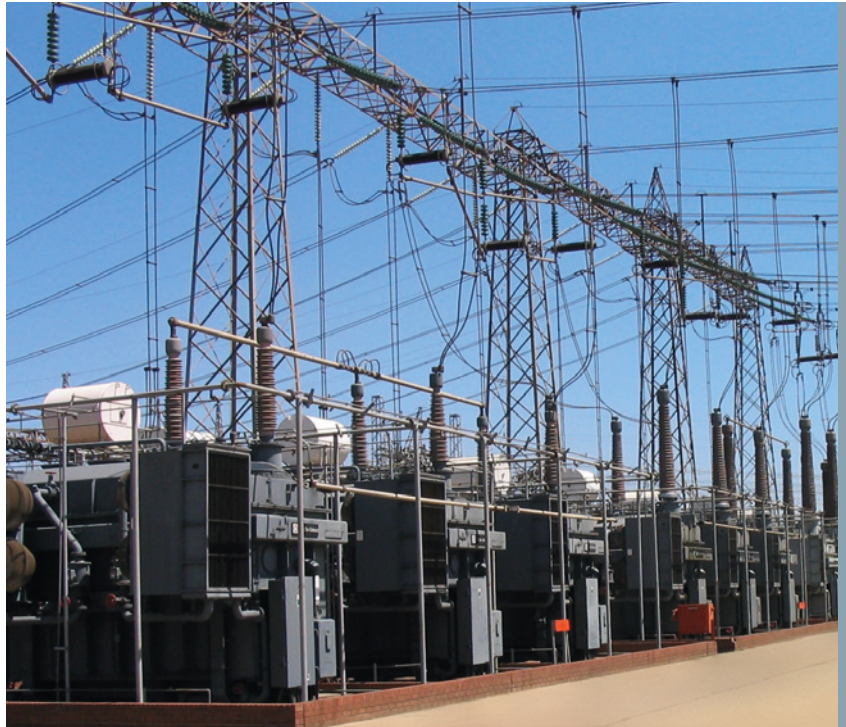
Als teuerste und ausfallsensitive Versorgungskomponenten erfordern Transformatoren besondere Aufmerksamkeit.
